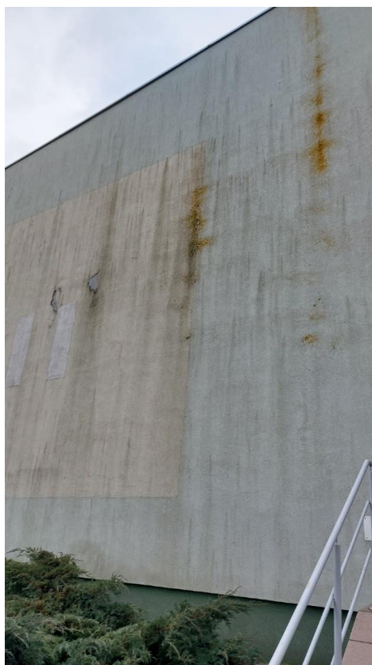
FOT. NR 6 – WIDOCZNE SPĘKANIA NA ELEWACJI SALI GIMNASTYCZNEJ
