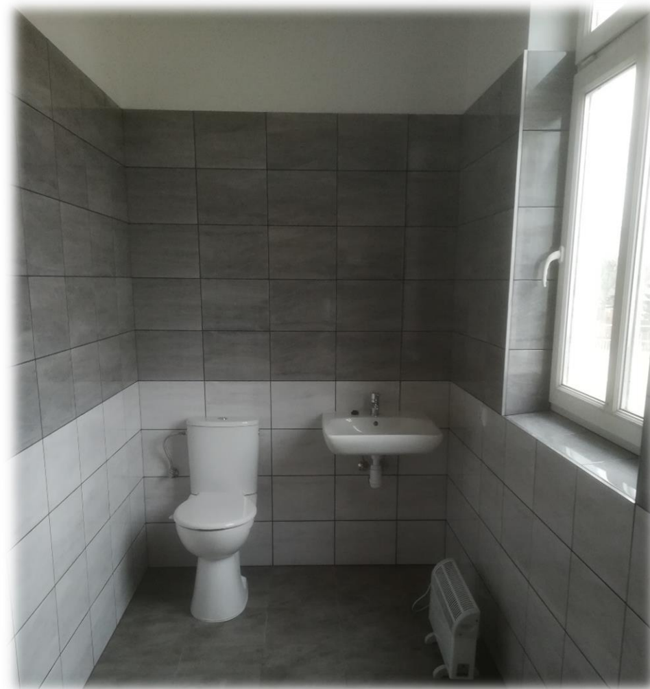
Remont świetlicy w miejscowości Czarna Średnia
